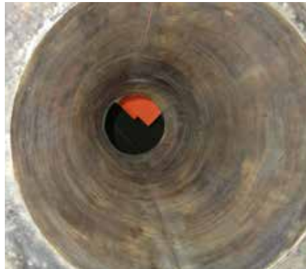
Cono de acero antes del recubrimiento
