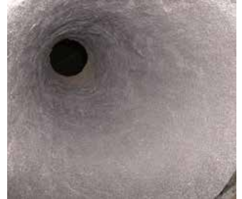
Cono de acero recubierto con Belzona 1812
